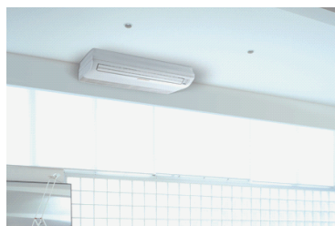
Installation au plafond
